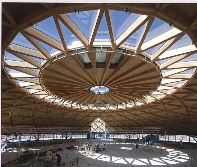
Eine weitere Schlüsselstelle bei der Konstruktion eines Zollingerdaches liegt darin, die optimale Stabgeometrie zu finden, die eine hohe Passgenauigkeit zulässt. Denn sie bestimmt das Gelingen und die Wirtschaftlichkeit dieser Konstruktion. Dadurch dass jedoch alle Stäbe des Dachtragwerkes den gleichen Zuschnitt erhalten – Sonderstäbe gibt es nur bei den Randanschlüssen – kann der maschinelle Abbund meist mit relativ geringem Programmieraufwand erfolgen.
