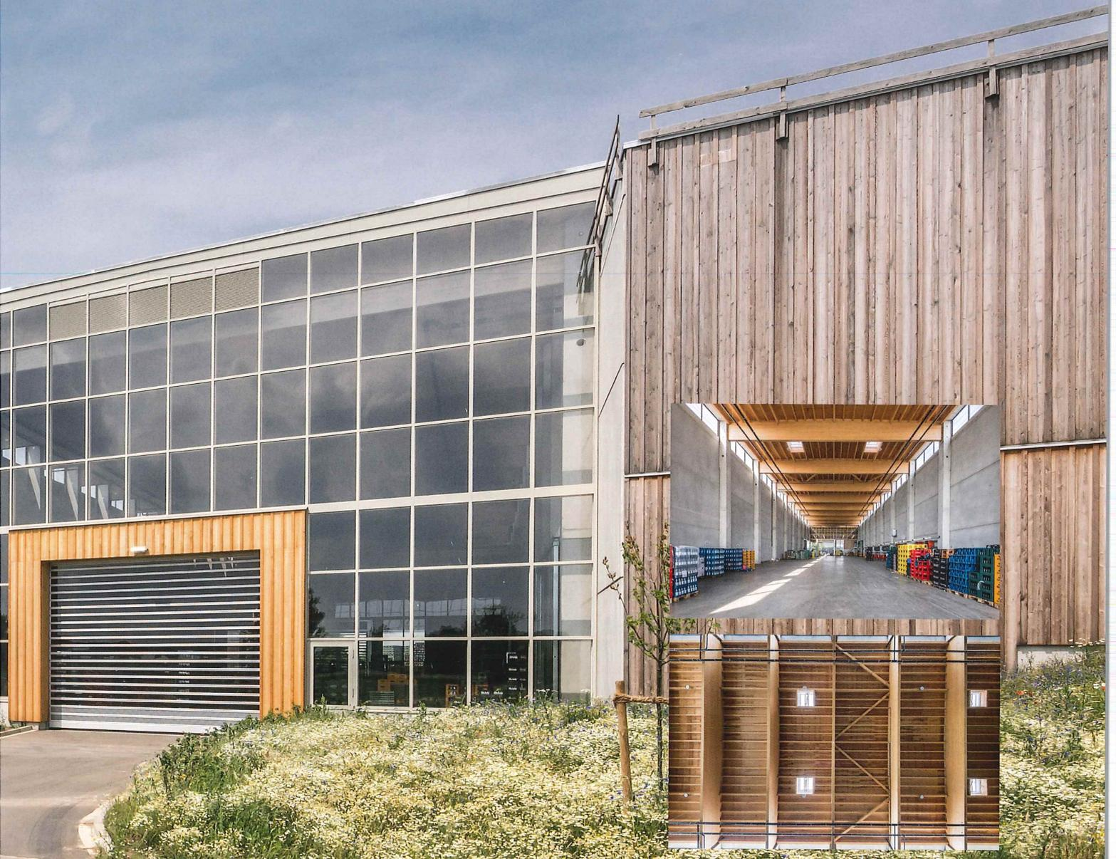
und überhöhte Zangenunterzüge ein, die die Dachlasten aufnehmen und in die Stahlbeton-Stützen ableiten.
